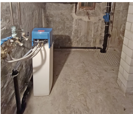
Wasserenthärtungsanlage
