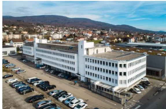
Oberstes Stockwerk und Dachterrasse
