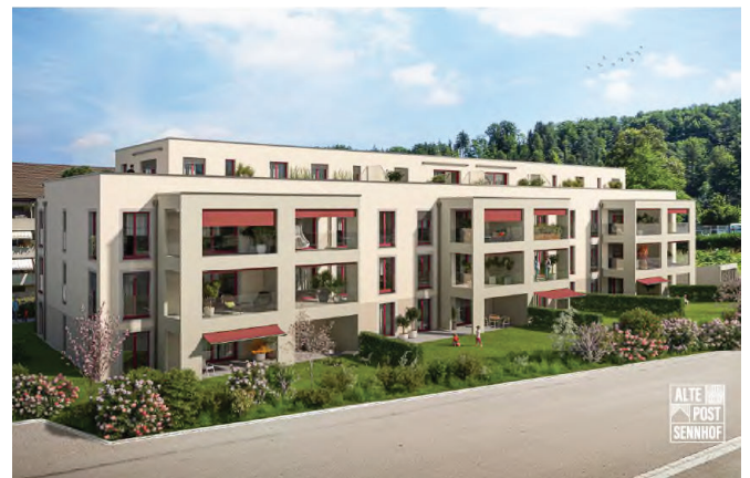
Aussenansicht, Tösstalstrasse 375, 8482 Sennhof (Winterthur)
