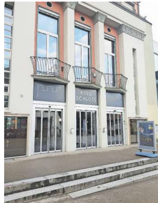
Soll innen im grossen Stil umgebaut werden: das Kino Schloss am Schlossplatz.
