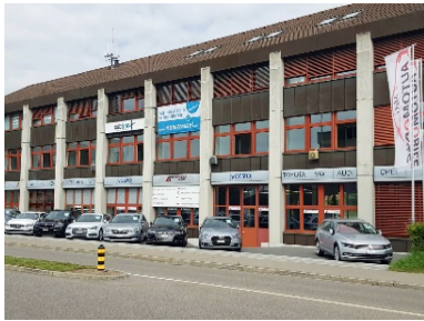
Gebäude von der Dorfstrasse
