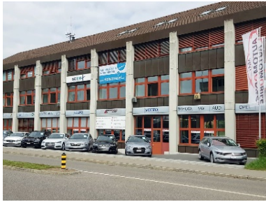
Gebäude von der Dorfstrasse
