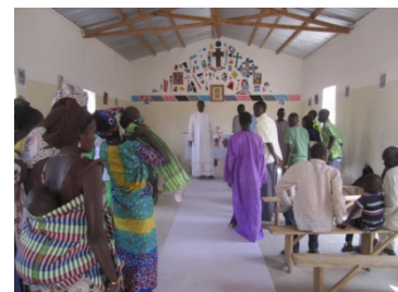
Innenrenovation der Kirche
